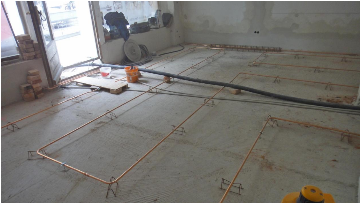
Einfache Höheneinrichtung von Heizrohren durch Abschnitte von sog. Unterstützungskörpern (s. Bildhintergrund)
