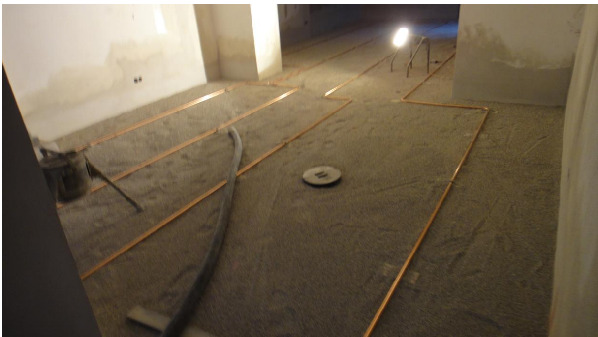
ausgerichtete Oberfläche der Splittschüttung
