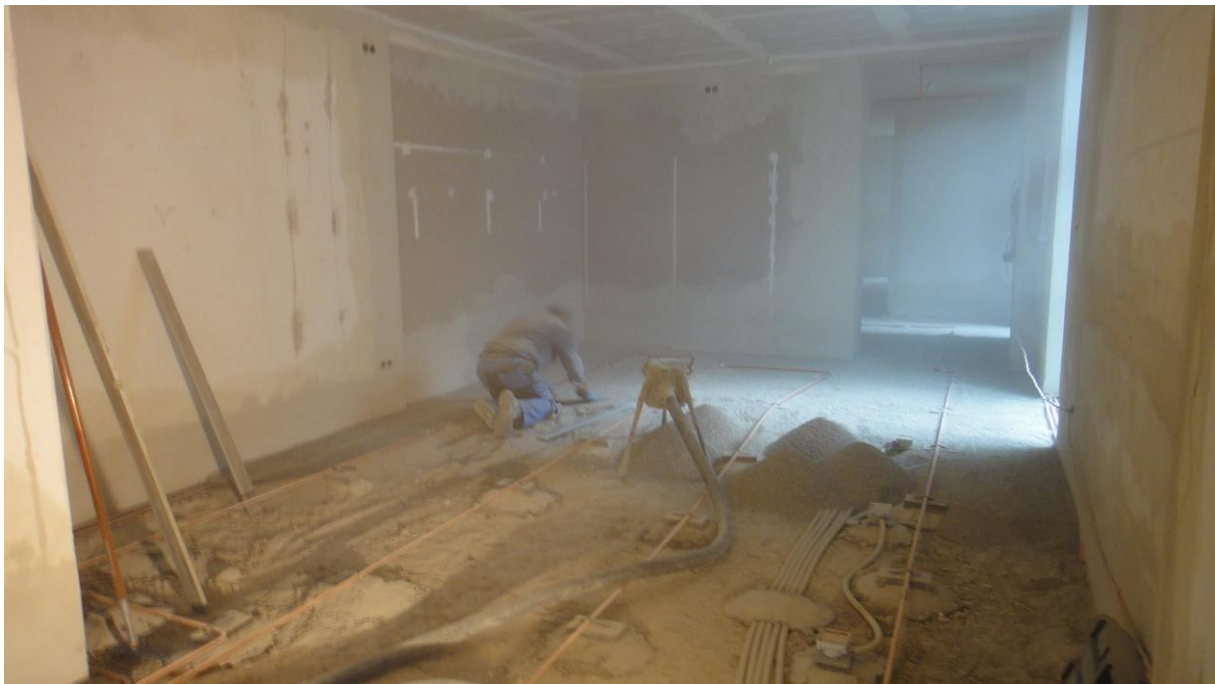
Die mineralische Schüttung erlaubt eine zügige Einbettung von Leitungen, Bodentanks etc.
