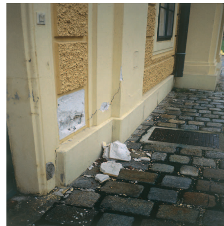
Abbildung 6b: Wagenburg in Schönbrunn, Eingang zur Restaurierwerkstätte. Die unterlassene Feuchtesanierung führte zum Absprengen des neuen „Sanierputzes“, Zustand 1995. Aufnahme Autorin.
