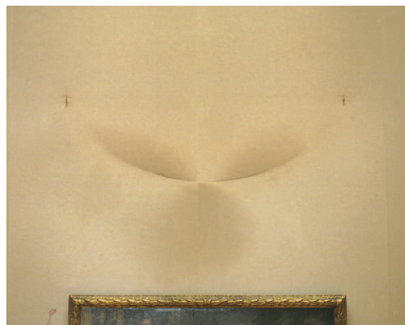
Abbildung 10b: Einblick in Saal III der Gemäldegalerie des Kunsthistorischen Museums, vor Sanierung im Zustand 1990. Auf der Wandbespannung zeichnen sich Luftstromverlauf zur Kalten Wand und Staubanlagerungen um das hier hängende Rundbild von Veronese ab. Aufnahme Margarete Neundlinger, Wien.
