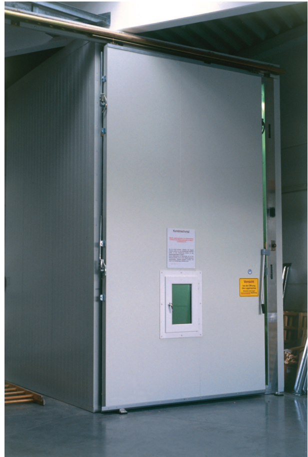
Abbildung 18b: Die neue, 1998 in Betrieb genommene Inertbegasungsanlage im neuen Depot des KHM. Aufnahme Autorin.
