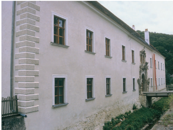
Abbildung 20b: Karthause Mauerbach bei Wien, Eingangsfront mit der dahinterliegenden um 1991 temperierten Hausbesorgerwohnung. Die extrem dicken Mauern sind inzwischen trocken und zeigen kaum mehr Feuchtflecken. Aufnahme 2002, Autorin.
