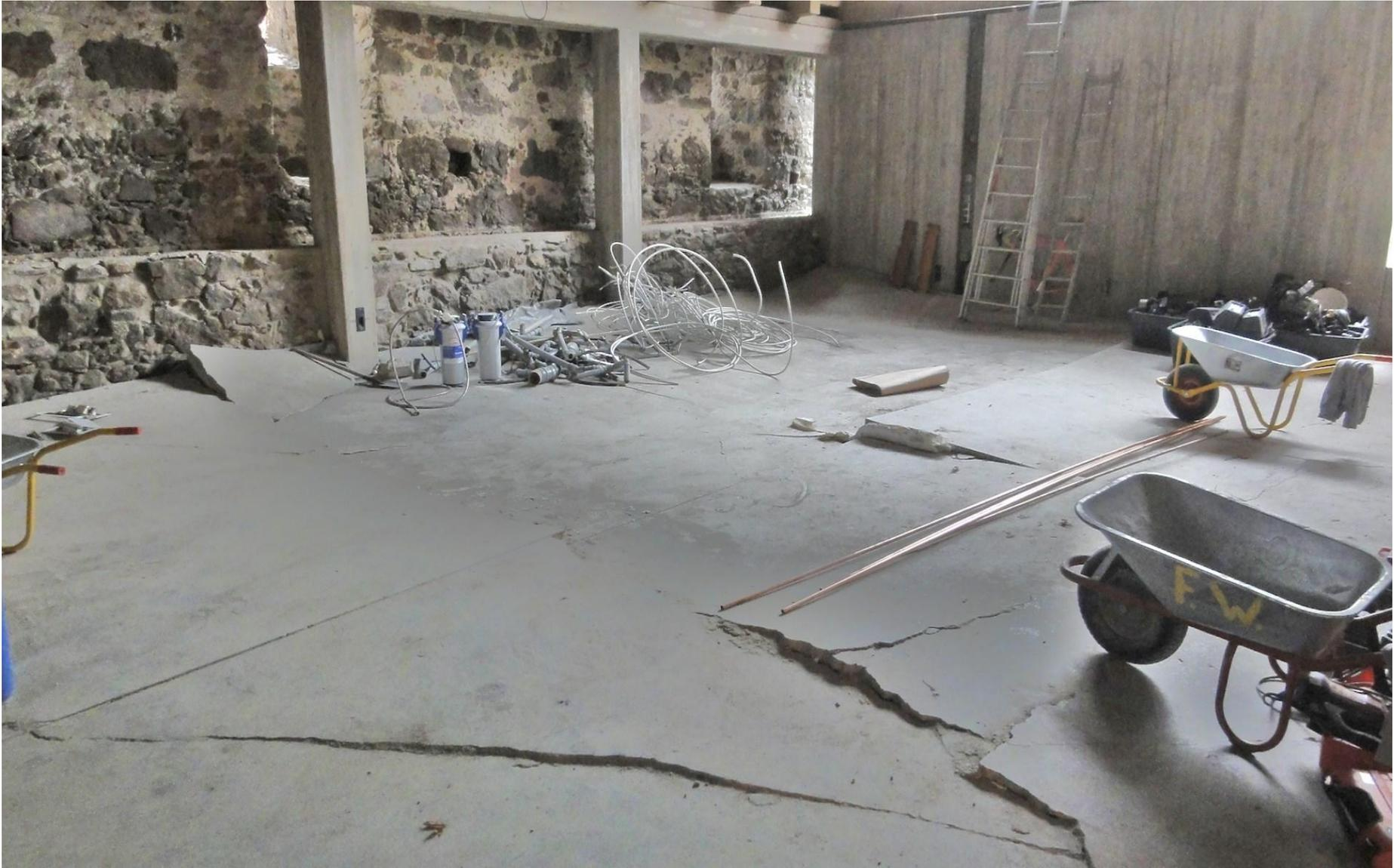
Uuuups, plötzlicher Dauerregen konnte über eine 4 m breite Fehlstelle der Dränagen-Kiesschicht den Betonkeller anheben, da er DIN-gemäß auf Kies (kapillarbrechende Schicht) gebaut war
