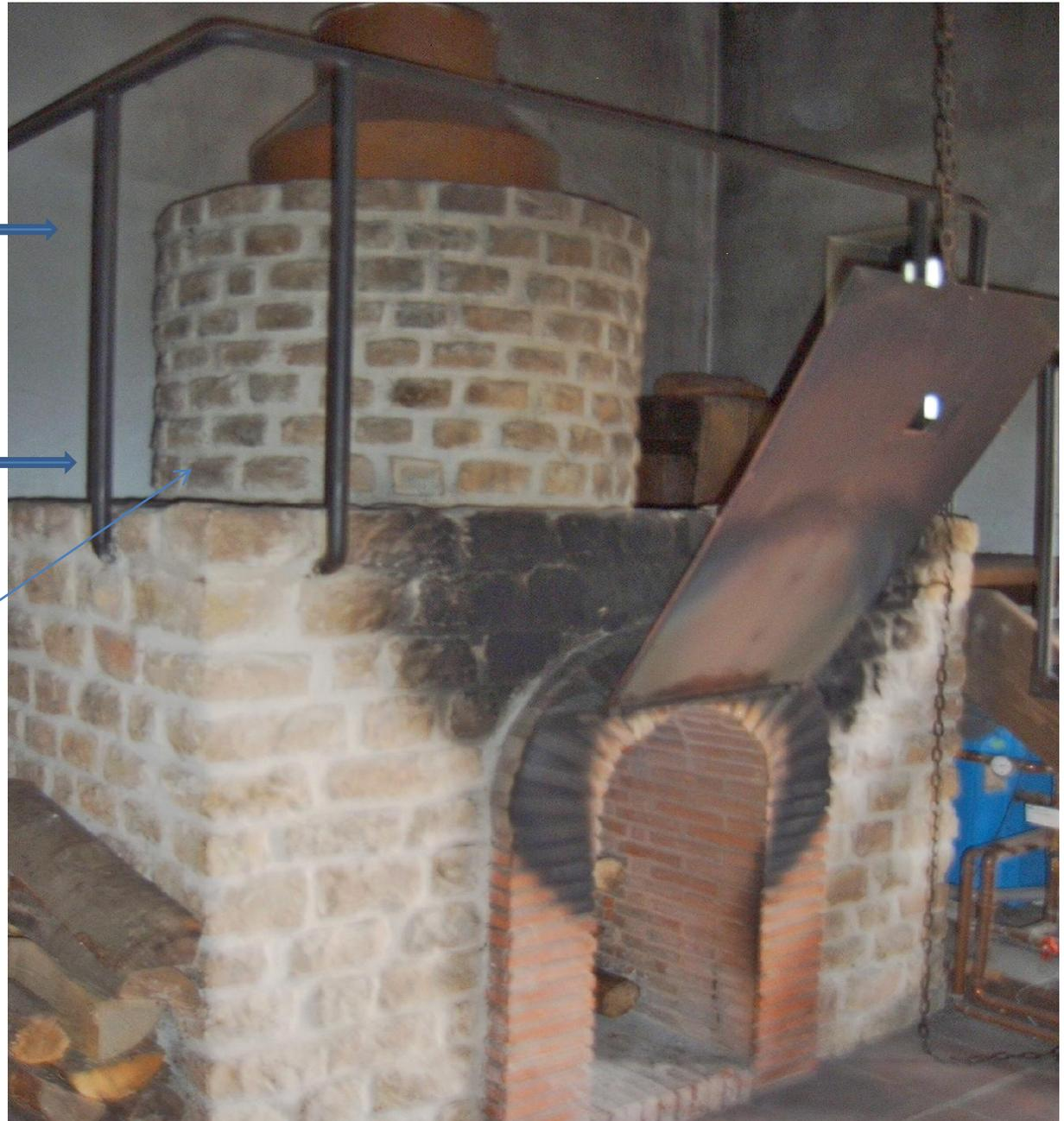
Heizungspuffer römisch: „Dämmung“ durch Speichermasse (Wandmasse der Raumecke, 2 neue Wände, Sand)
